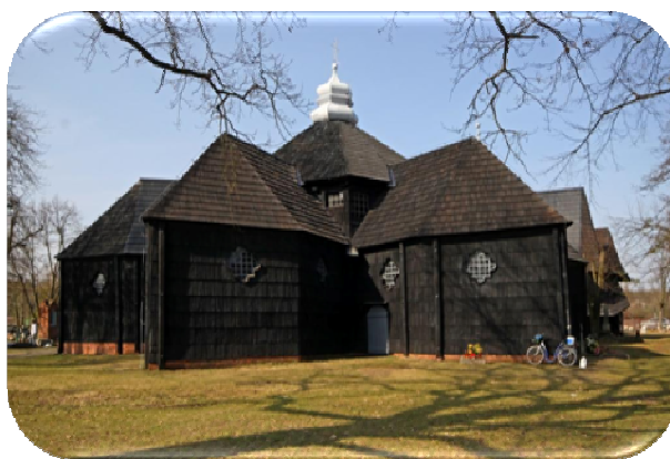
Fot. Wykonanie systemu przeciwpożarowego w XVI w. drewnianym Kościele św. Anny w Oleśnie
