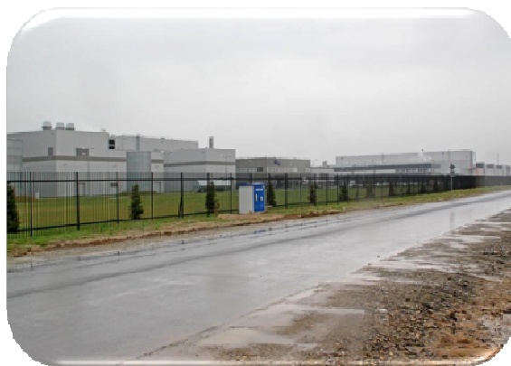
Fot. Przebudowa drogi gminnej przebiegającej wzdłuż terenów inwestycyjnych
