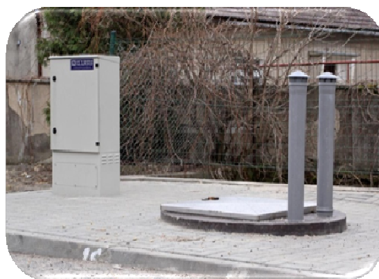
Fot. Budowa kanalizacji sanitarnej i wymiany sieci wodociągowej dla wsi Klucz, Olszowa wraz z osiedlem mieszkaniowym Księży Las i SAG Olszowa
