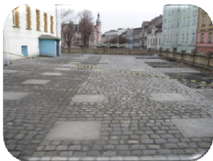
Fot. III etap rewitalizacji infrastruktury śródmieścia Prudnika
