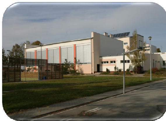
Fot. Termomodernizacja budynku Publicznego Gimnazjum nr 5 w Kluczborku
