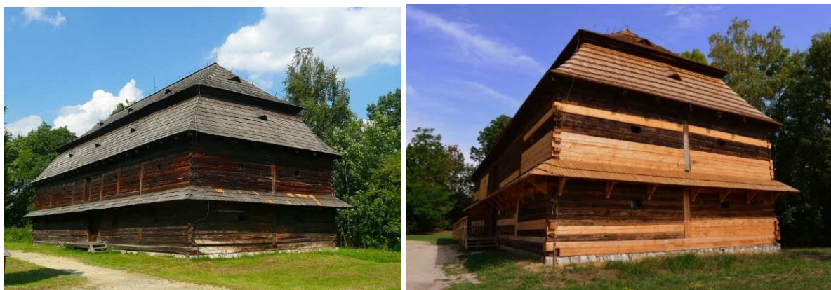
Ryc. 4 Muzeum Wsi Opolskiej w Opolu. Spichlerz dworski ze Sławięcice przed i po pracach remontowych, fot. ze zbiorów MWO w Opolu
