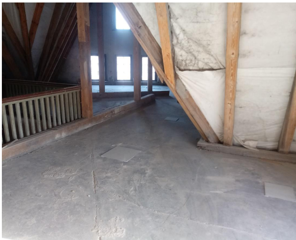
Strop po dociepleniu
