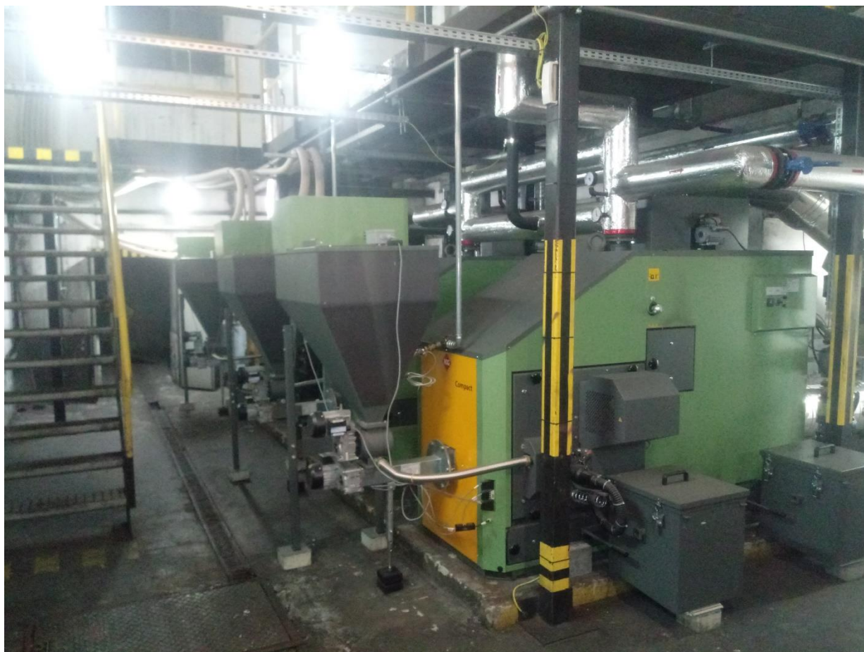
Kotłownia po remoncie
