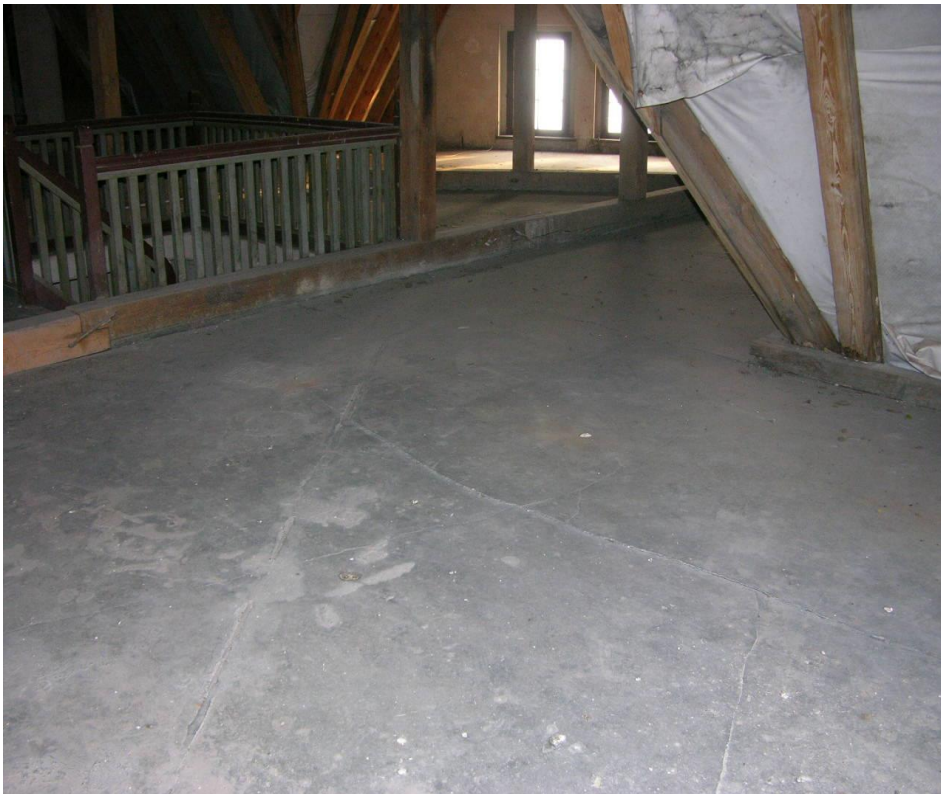
Strop przed dociepleniem
