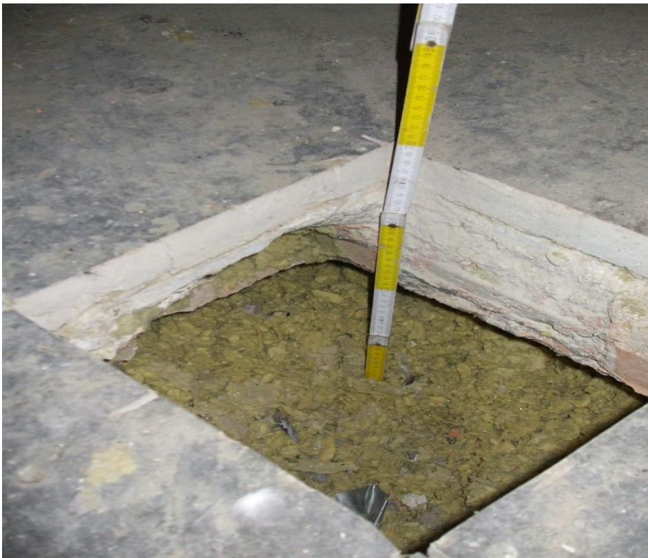
Strop w trakcie docieplania
