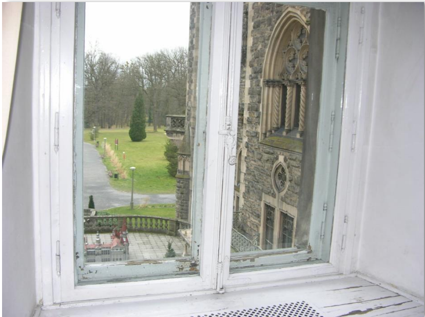
Stolarka okienna w bibliotece przed renowacją
