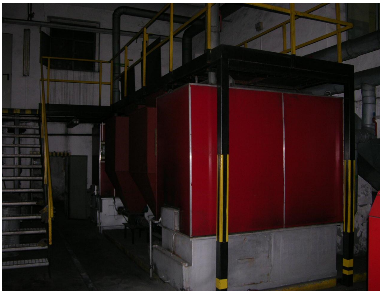
Kotłownia przed remontem
