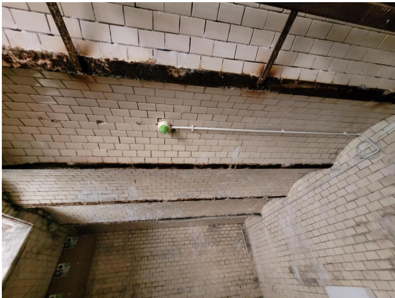
Widok na istniejące okładziny
