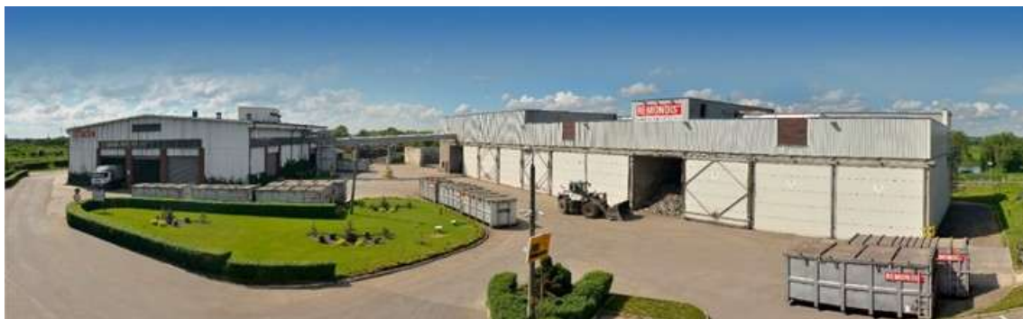
Rysunek 62. Widok na instalację MBP zlokalizowaną w Opolu 144
